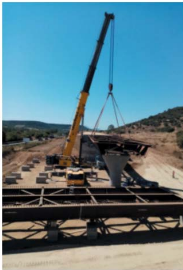
●●●● SVILUPPO Lavori su una strada della Sardegna in una foto d'archivio
